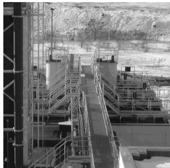
Abb. 2: Ansichten der Neutralisationskaskaden in den HDS-Anlagen der WISMUT in Königstein (links) und Ronneburg (rechts) – jeweils vierstufig in zwei Straßen.
